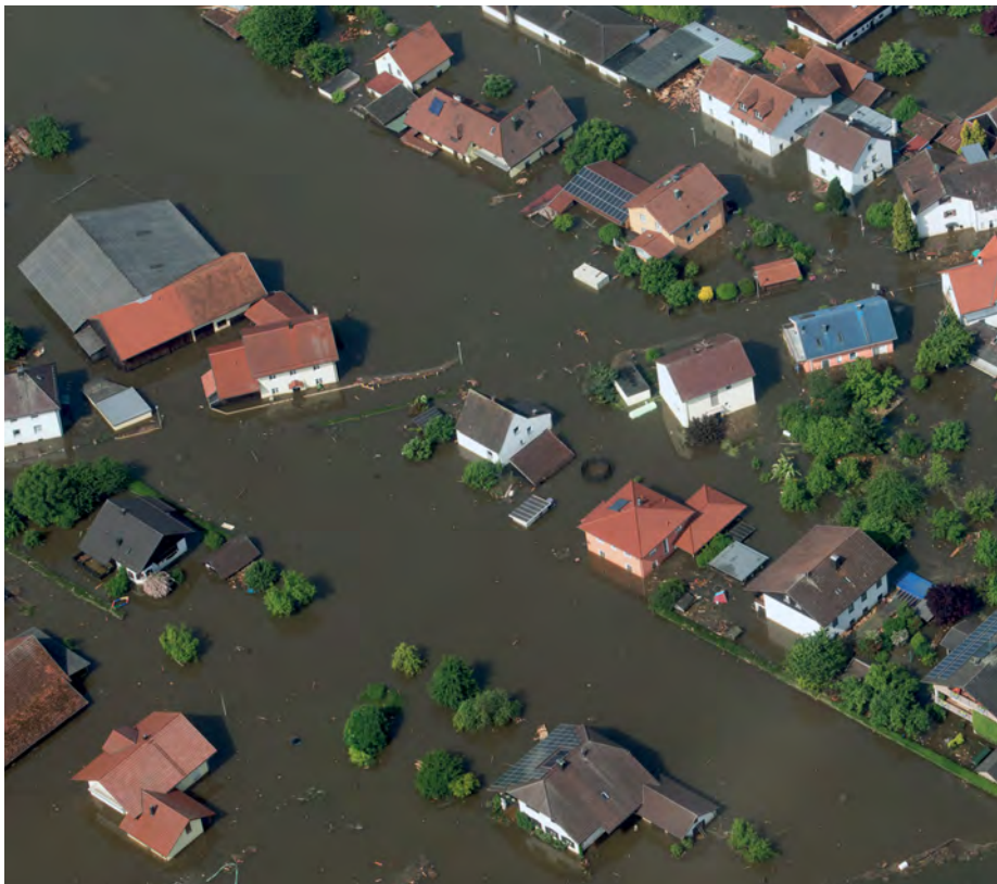
Der Deggendorfer Stadtteil Fischerdorf versank im Juni 2013 komplett im Hochwasser der Donau. Ausgelaufenes Heizöl zog in die Wände ein und machte viele Gebäude unbewohnbar. Weil es keine Grenzwerte gab, erarbeitete das IFS eigene Empfehlungen zur Sanierung. Letztlich blieb vielen Bauherren nichts anderes übrig, als ihr Haus zurück in den Rohbauzustand zu versetzen. Foto: dpa
