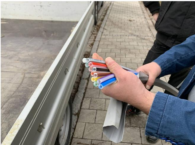
Für jeden Anschluss eine Farbe: Die eigentlichen Glasfasern werden erst zum Schluss in die einzelnen Leerrohre eingeblasen, wenn das Netz bereits im Boden liegt.
