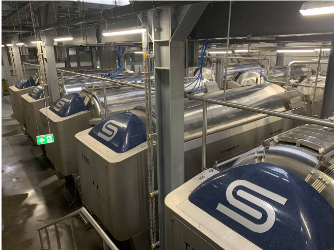
Die neue Kelterstation der GWF: 16 Millionen Euro hat die Genossenschaft in das Projekt investiert. Foto: Florian Christner
